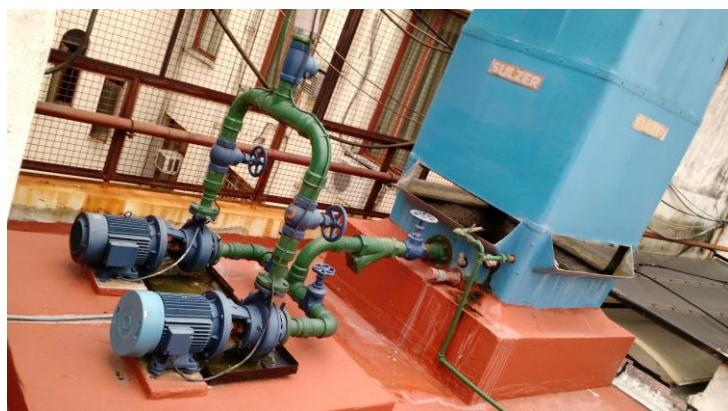
**5.1.2. PEDESTALES:** Ejecución de pedestales de mampostería revocados con material cementicio con tratamiento hidrófugo y aislado por membrana asfáltica, distantes de acuerdo a la dimensión total de cada base de los equipos detallados a continuación:
