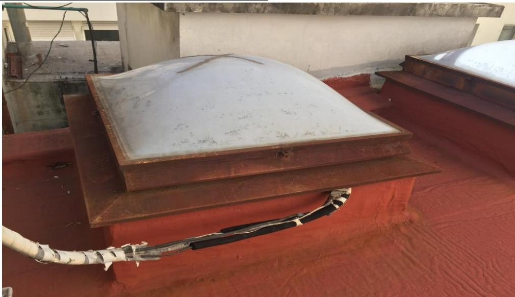
**5.5.1. Cambio de claraboya:** Se reemplazará la claraboya de policarbonato dañada por una de las mismas características que la existente. Se ejecutarán todas las tareas necesarias para la correcta terminación de la labor.
