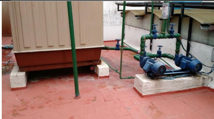
**5.1.1.2. Plataforma N°2:** (Torre Sulzer) Se proveerá y colocará una base metálica cuyas dimensiones serán de 2.600 mm x 1.200 mm. Se montará sobre 4 (cuatro) pedestales cementicios de 300 mm x 300 mm y 300 mm de altura cada uno.
