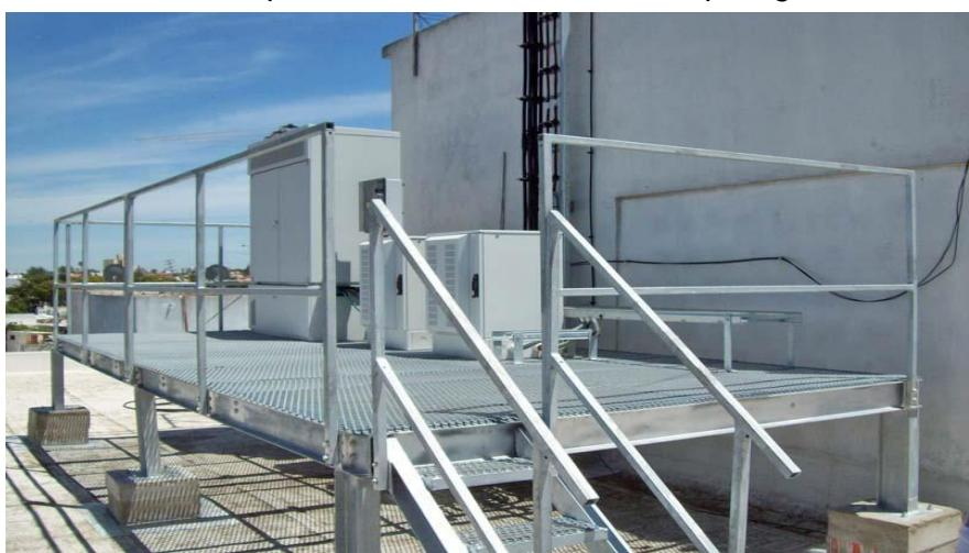
Por las dimensiones de las plataformas se deberán agregar 2 (dos) travesaños de perfil H N°8, de 80 mm en el lado mas corto de la plataforma y perpendicularmente a estos se deberán agregar 3 (tres) hierros L de 50 mm x 50 mm x 5 mm, equidistantes entre si.
