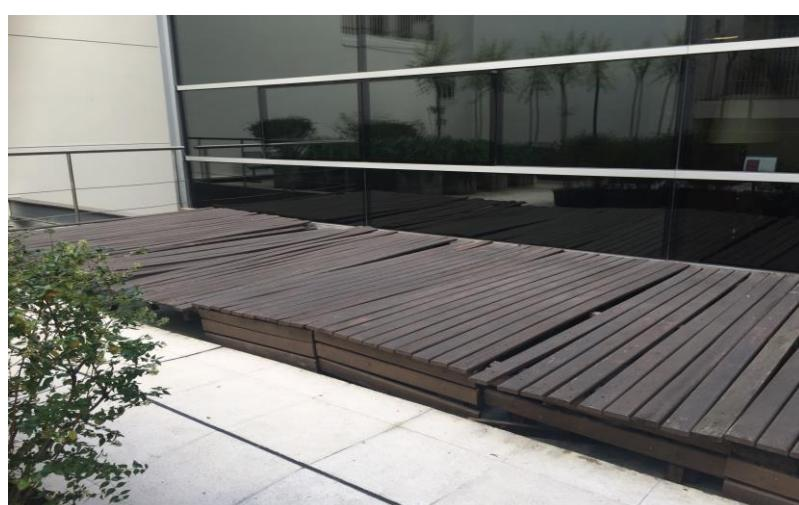
**5.10.1.** *Se retirará el Deck de madera existente en la terraza del piso 1°. Se nivelará la superficie con un contrapiso de hormigón alivianado con arcilla expandida y una pendiente mínima del 1% (uno por ciento) hacia los embudos. Sobre este contrapiso, se ejecutará una carpeta de alisado de cemento con dosificación 1: ¼ : 4 (cemento, cal y arena). Se*
