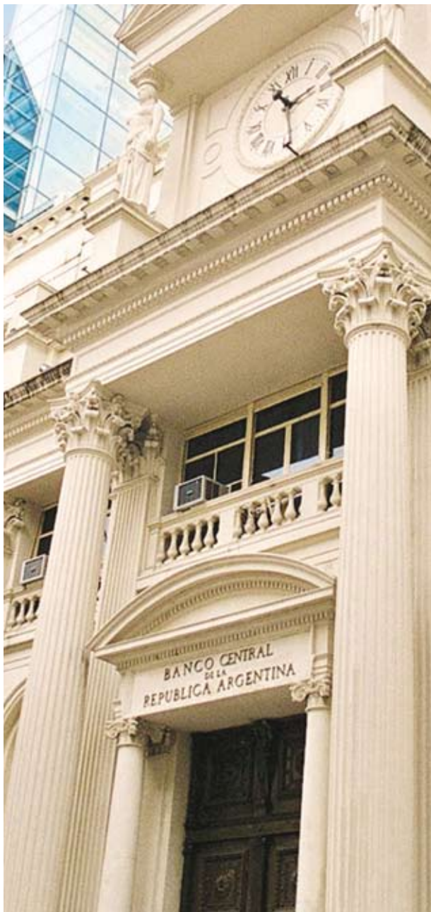
Fachada del edificio Reconquista 266
